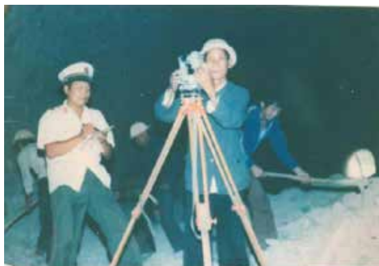
张有臣在修路工地测绘
