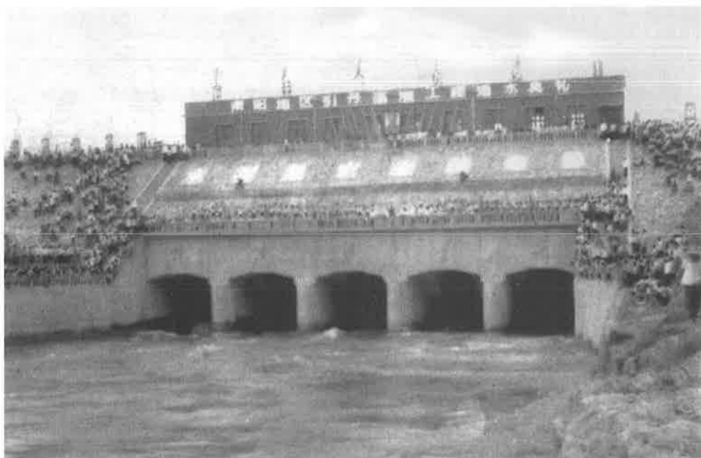
1969年至1976年,南阳人民在极端困难的条件下,用8年时间高标准建成南水北调中线渠首——陶岔渠首。图为1974年8月16日,陶岔渠首建成通水。
