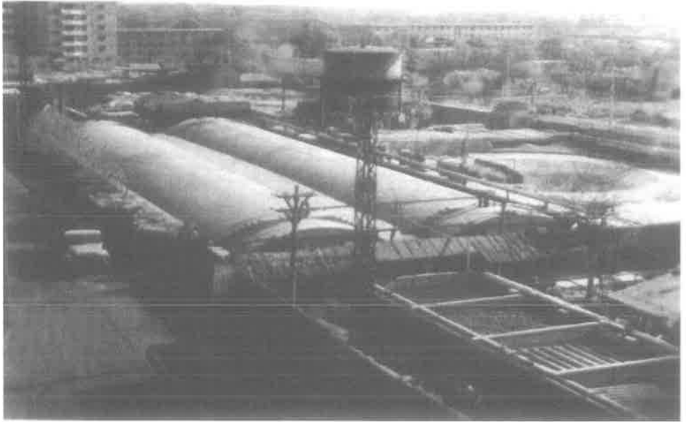
南阳酒精厂1967年自行设计建造厌氧沼气发酵池，开创我国工业沼气的先河。1970年又对沼气使用进行开发研究，实现了沼气发电。图为 2 \times 2000\text{m}^3 沼气发酵池。
