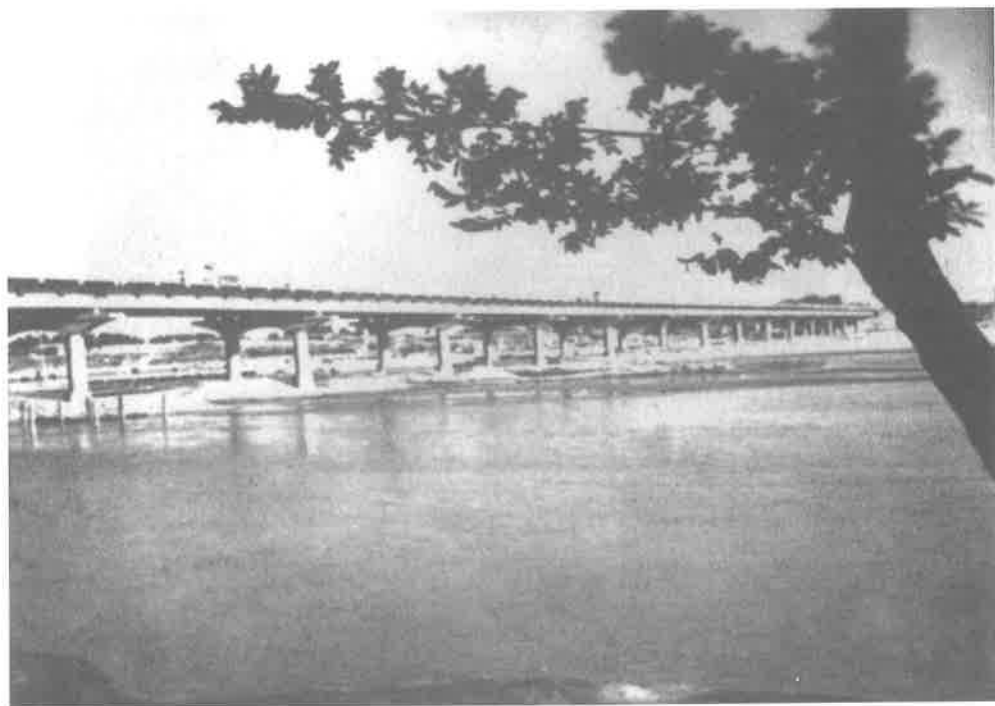
1965年6月1日，南阳白河大桥建成通车，从根本上改变了南阳城区南北相隔的交通面貌。
