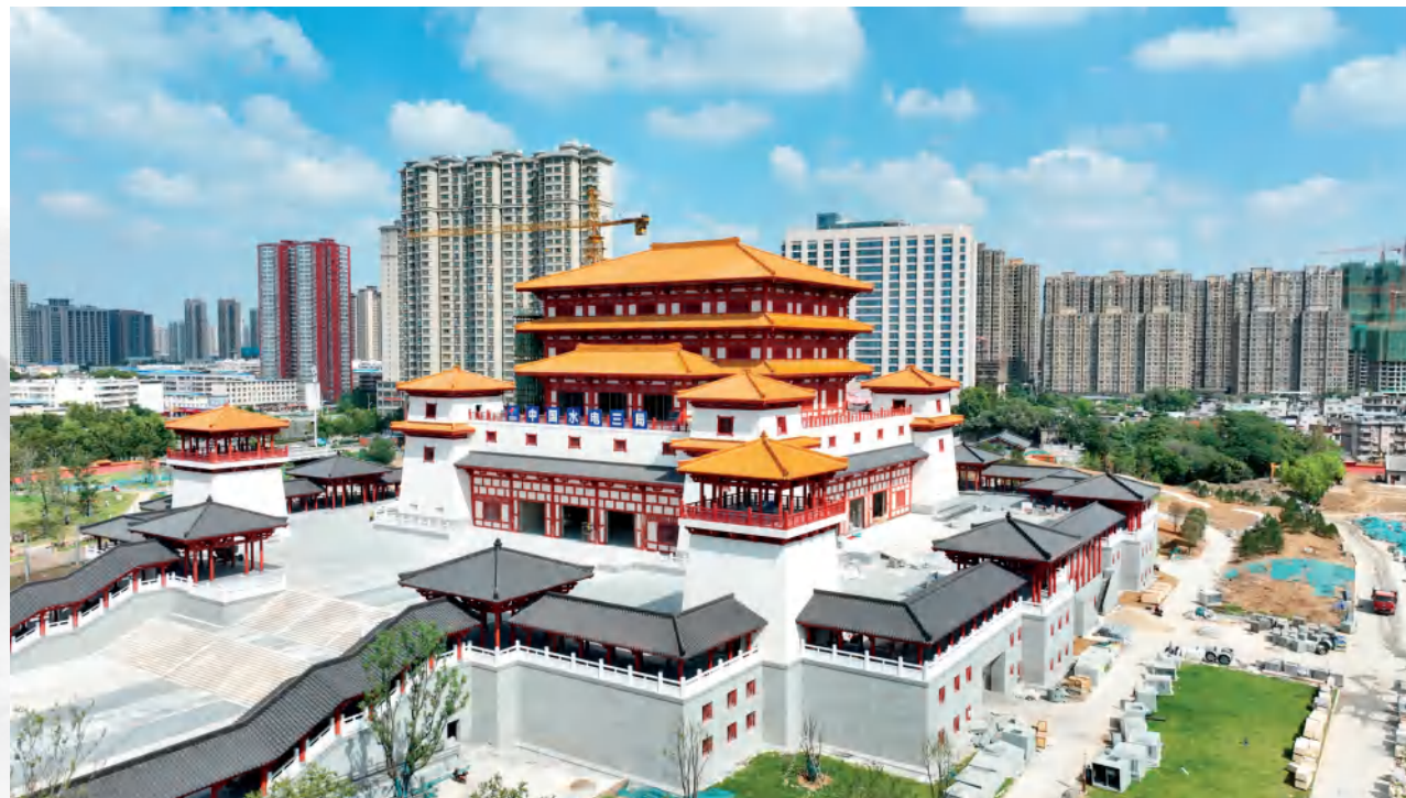
建设中的医圣文化园（吴德江 / 摄影）
