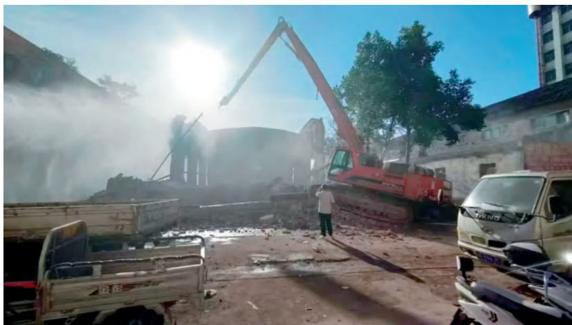
2023年7月7日上午，光武路光辉机械厂拆除工程正式启动 (汉冶街道 / 供图)
