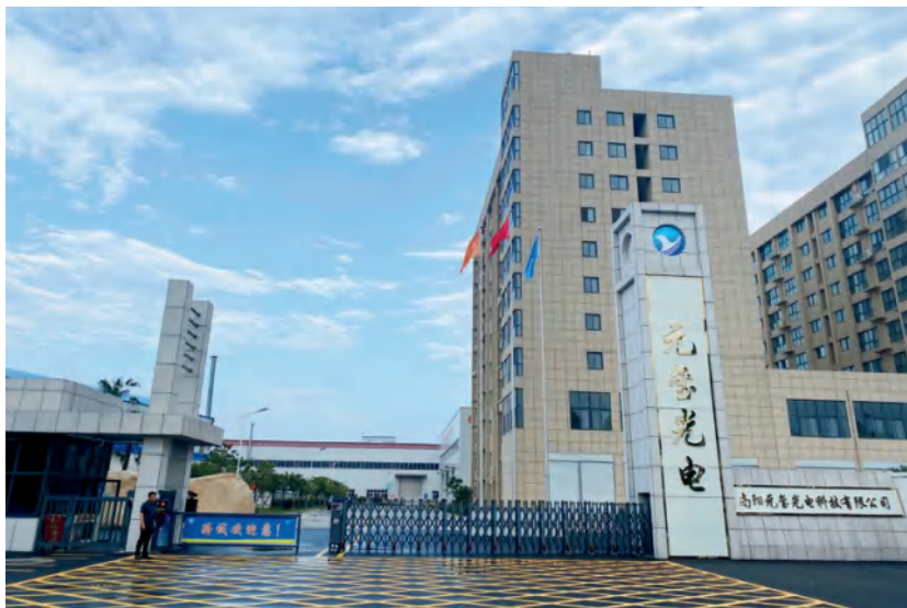
南阳元玺光电科技有限公司 5G 光电新材料生产项目（金华镇 / 供图）
