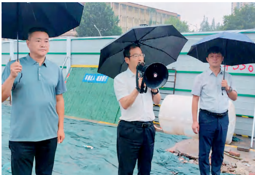
2023年8月21日上午，宛城区汉冶街道组织对光武路光武宾馆进行依法拆除（汉冶街道 / 供图）
