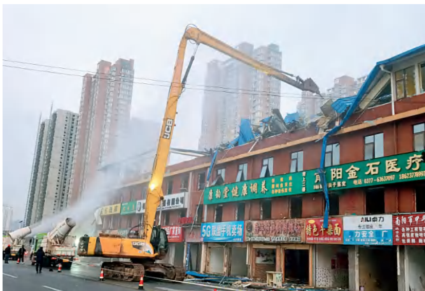
2023年6月，宛城区汉城河片区光武路拆迁塑料厂 （区城市更新中心 / 供图）
